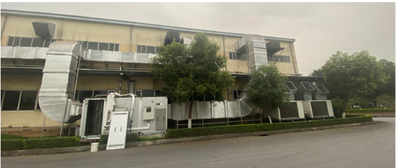
Công trình Đầu tư cải thiện môi trường khoang sợi thành phẩm của Phân xưởng Sợi Công ty Thuốc lá Thăng Long
